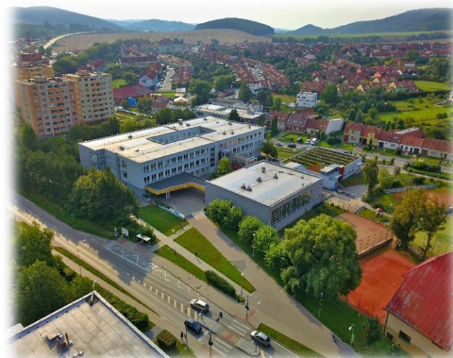
Budova na ulici Tyršova
